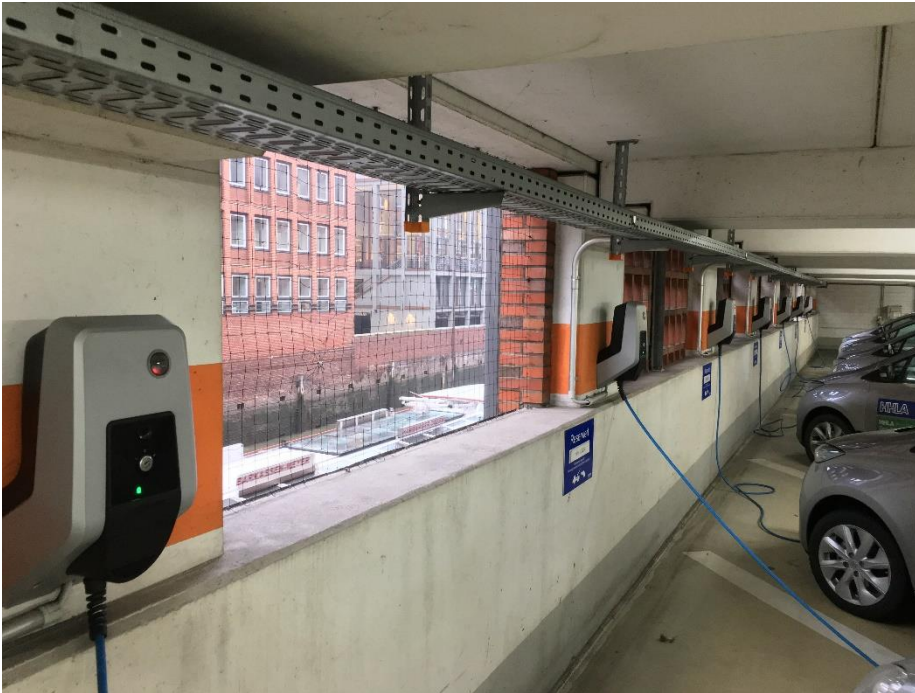
Parkhaus Hamburg Speicherstadt
